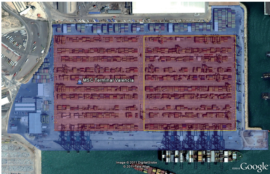
Figura 48. Área de patio de RTGs (6+1) en MSC Terminal Valencia (Valencia - España)
