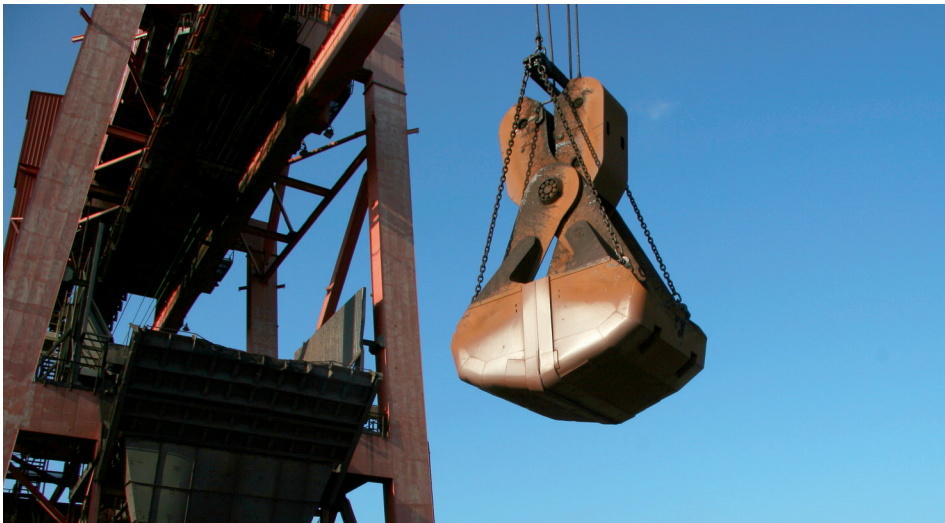
Figura 13. Sistema de tolva y cuchara en El Musel (Puerto de Gijón - España)
