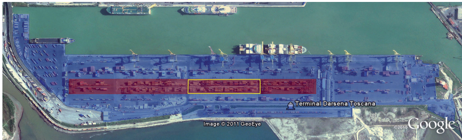
Figura 49. Área de patio de RTGs (6+1) en Terminal Darsena Toscana (Livorno - Italia)
