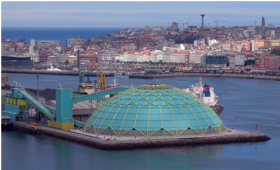
Figura 14. Instalación especial "Medusa" de descarga de granel (A Coruña - España)
