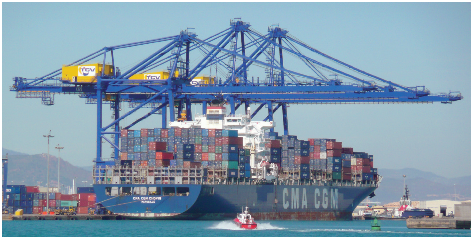
Figura 56. Grúas super-post panamax . Terminal TCV. Puerto de Valencia
