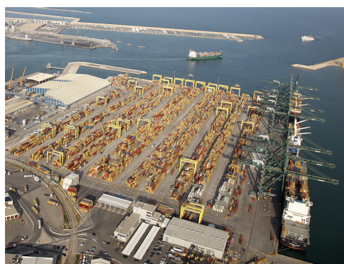
Figura 96. Patio de RTGs
